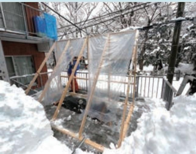
図4-1 2×4材を用いた骨組み。以下、「準備期間」中のすべての作業は、主査と副査の二人で行っている。
