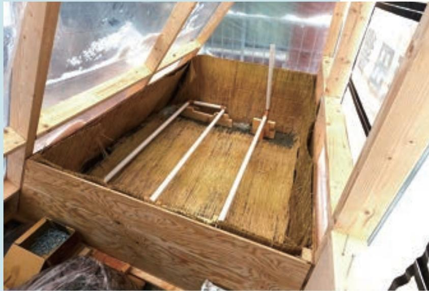
写真4-4 テント内部。アースパイプを仕込んだ温床用の木枠。壁と床にむしろを敷いている
