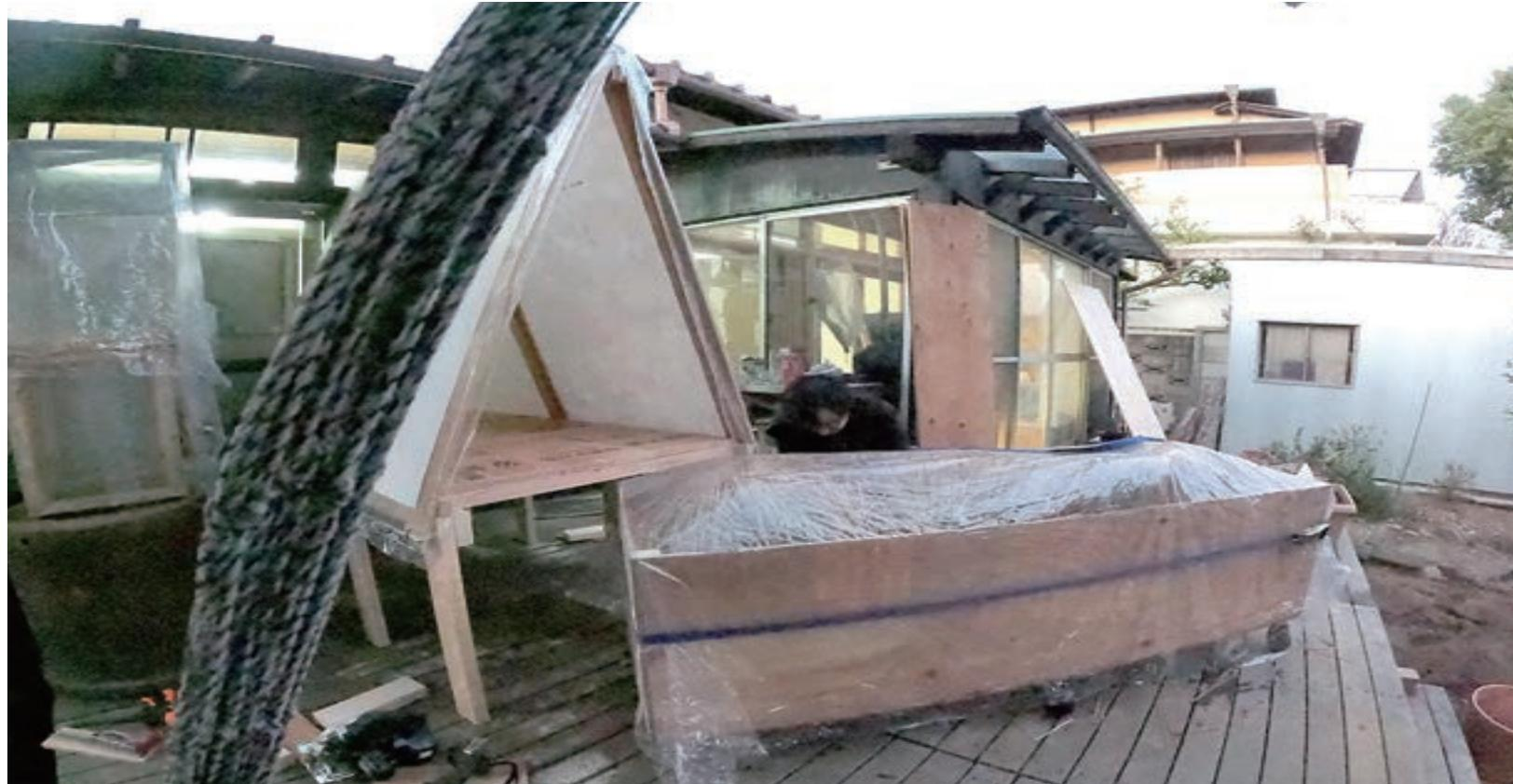
写真 5-1 制作したテント。高床式になっており、床下にキャスターのついた温床が収納できるようになっている
