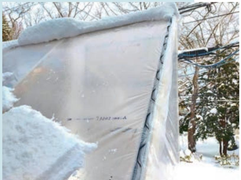
写真4-2 銀色のレール状のものがビニペット。専用の黒いスプリングを用いてくぼみの部分にビニールを挟み込むようにして使う。農業用資材を扱っているホームセンターで入手できる。
