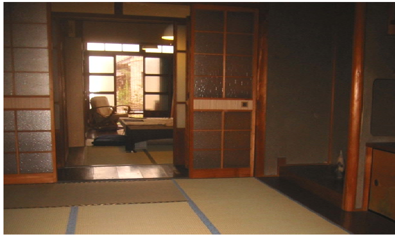
写真3-2 うなぎの寝床改修中
