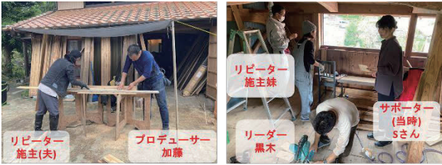
図 5-3 天井板加工(左)と天井板張り(右)の様子
