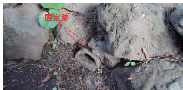
写真 2-4 枯池護岸の土管による給水口と固定跡
