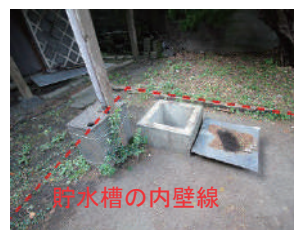
写真4-1 天水井戸Cの外観
