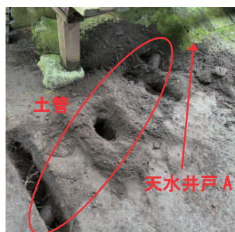
写真 2-7 天水井戸 A と枯池を 地中で繋ぐ給水用の土管
