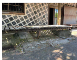
写真 2-5 枯池への給水跡 が確認できた天水井戸 A
