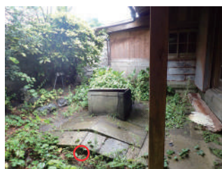
写真 2-8 天水井戸 B の貯水槽上部にある排水口の位置
