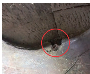
写真 2-9 天水井戸 B の貯水槽上部にみる排水口
