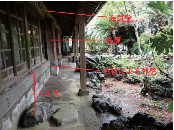
写真 4-3 沓脱石と海鼠壁をはじめとした防火用の設え
