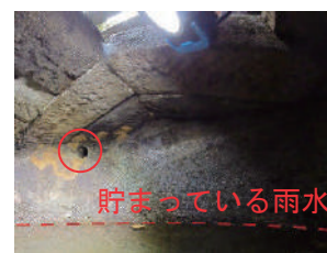
写真 2-6 天水井戸 A の貯水槽 槽上部にみる排水口と雨水
