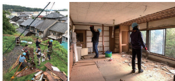
図3-9 空き家解体ワークショップ（丘の上の二軒長屋）
