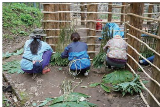
図 2-4 クマイザサの躯体への編み付け（2022 年 5 月）
