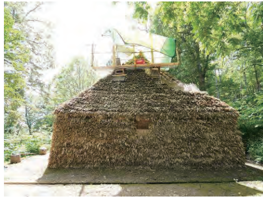
図 2-8 嵐山チセ・建設中外観（北側立面）（2022 年 7 月）
