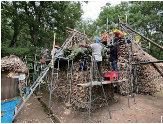
図 2-7 嵐山チセ・建設中外観（2022 年 7 月）
