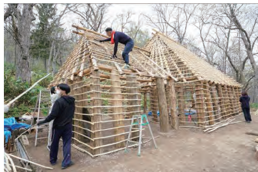
図 2-3 建設中の嵐山チセ・外観（2022 年 5 月）
