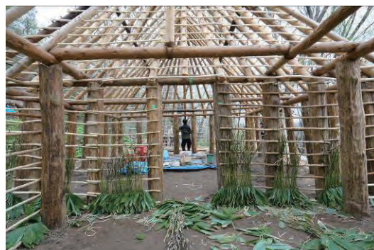
図 2-5 建設中の嵐山チセ・内観（2022 年 5 月）
