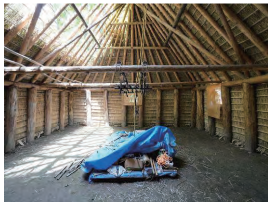
図 2-10 嵐山チセ・建設中母屋内観（2022 年 7 月）
