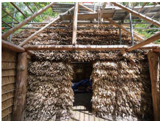
図 2-9 嵐山チセ・建設中セム内観（2022 年 7 月）
