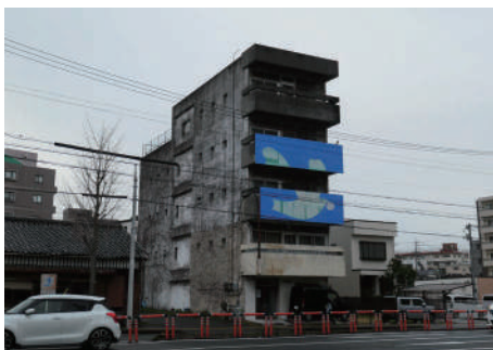
図3-16 浜優専門店会会館だった建物の現在の様子
