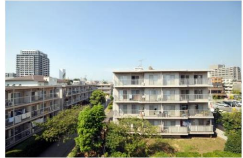
市ヶ谷加賀町アパート外観
