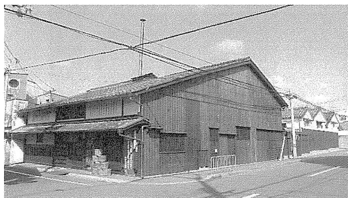
図-14 店舗の改修—3つの蔵のシンボル性を活かした景観づくり
