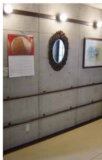
図6 和室の手すり
