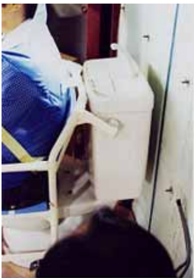
図6 トイレキャリアのハンドグリップがロータンクに当たっている
