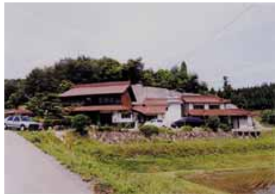
図1 増築前の全景
