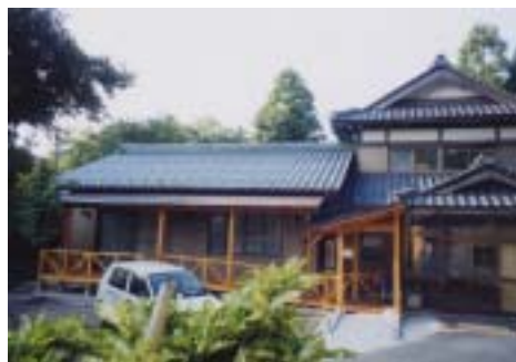
スライド2 改造後正面スロープ
