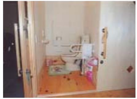
スライド3 改造後トイレ
