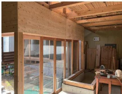
図 2-4. 上棟後建具工事
