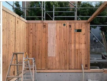
図 2-1. 柱・梁・壁パネルの建込み
