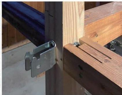
図 2-2. 金物を用いた柱梁接合部
