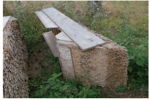
図 3-5 構法確認のためのモックアップ
