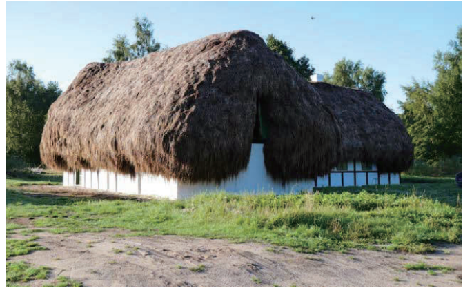
図 3-11 葺き替え直後の海藻葺き
