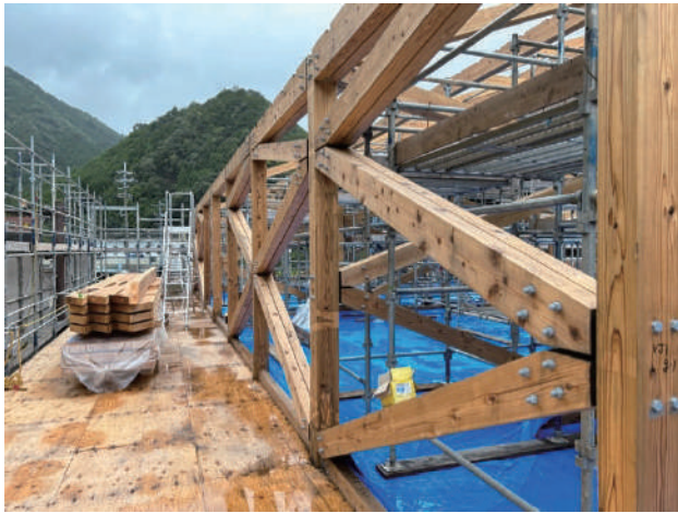
図 3-2 建設途中の災害対策本部拠点施設
