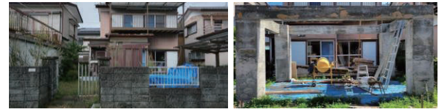
図 4-1 実践①の施工前（左）と現状（右）の様子
