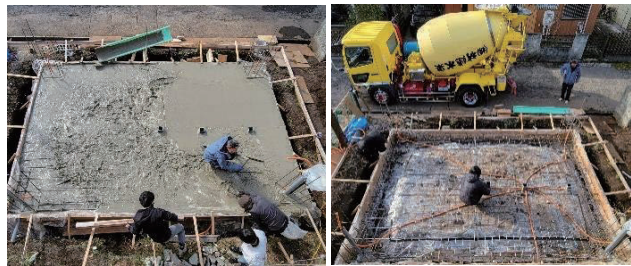
図 4-10 基礎のコンクリート打設の様子
