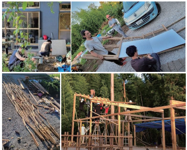
図 4-15 屋根作業の様子
