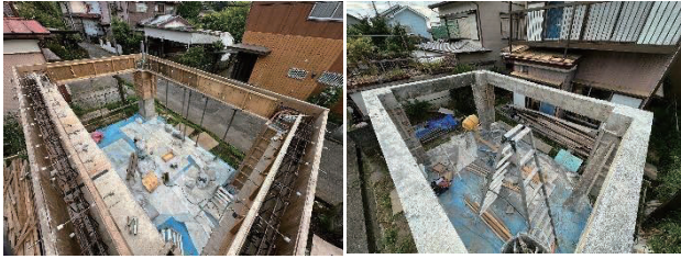
図 4-12 梁のコンクリート打設の様子
