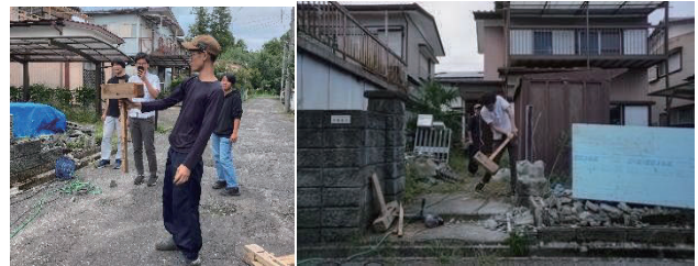
図 4-7 解体工程の様子
