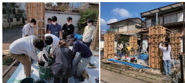
図 4-11 柱のコンクリート打設の様子
