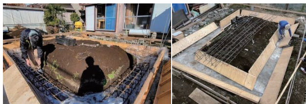
図 4-9 配筋工程の様子
