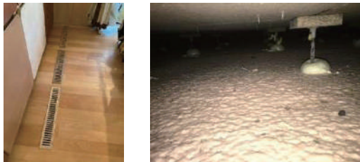
写真 2-5 給気ガラリ 写真 2-6 床下空間の状態
