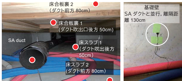
写真 2-3 気流測定をした床下空間
