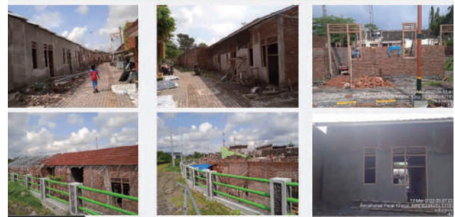
図 2-3 都市スラム再開発における住宅建設（RW 01 Mojo 地区）
