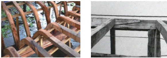
図 4-6 Castro での造船所の木船用の Diagonal simple (左)、Santa María de Nercón 教会修復用の棟木の Diagonal simple (右)。(Pulido, 2023. 堺, 2023)
