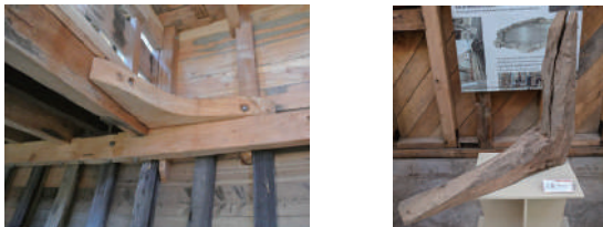
図 4-5 Ancud での造船所の木船用の Escuadra (左)、Fundación Iglesias de Chiloe 博物館での提示されている Tenaún 教会用の Escuadra (Pulido, 2023. 堺, 2023)
