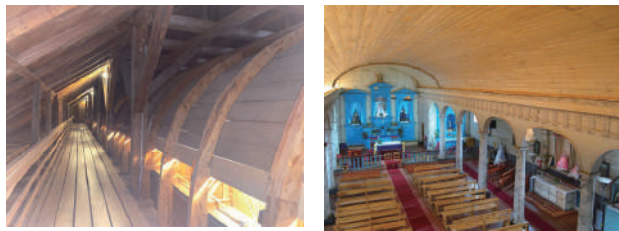
図 4-2 Santa María de Nercón 教会の二重屋根の間のスペース（左）、とその内部空間と内部の半円の天井（塚, 2023）
