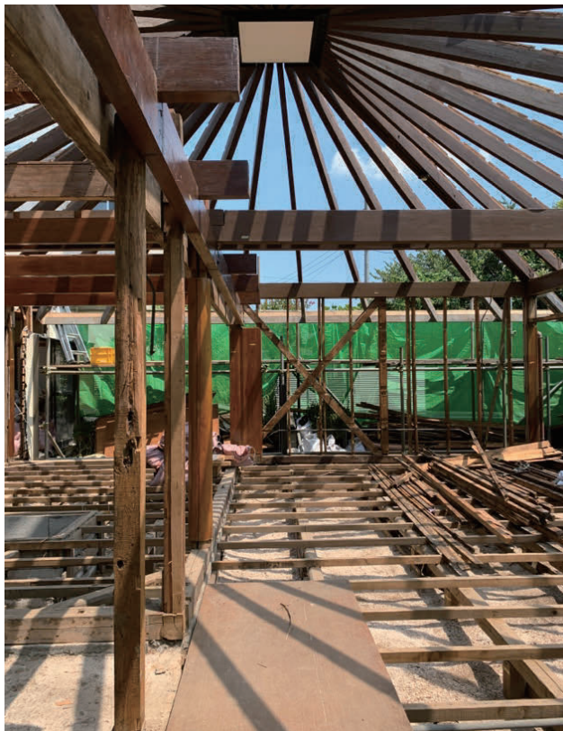
写真 2-2 解体工事の様子
