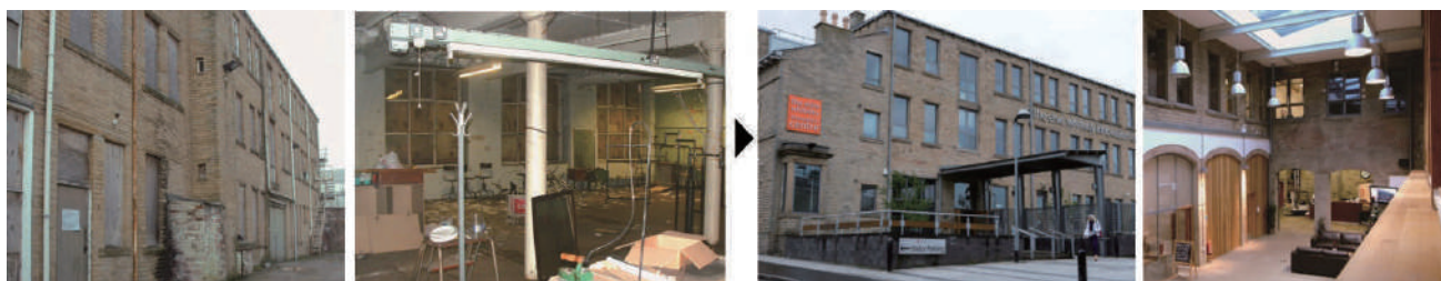
写真 5-1,2 EWIC 改修前（外観・内観）、写真 5-3,4 EWIC 改修後（外観・内観）（写真提供 HOT）
