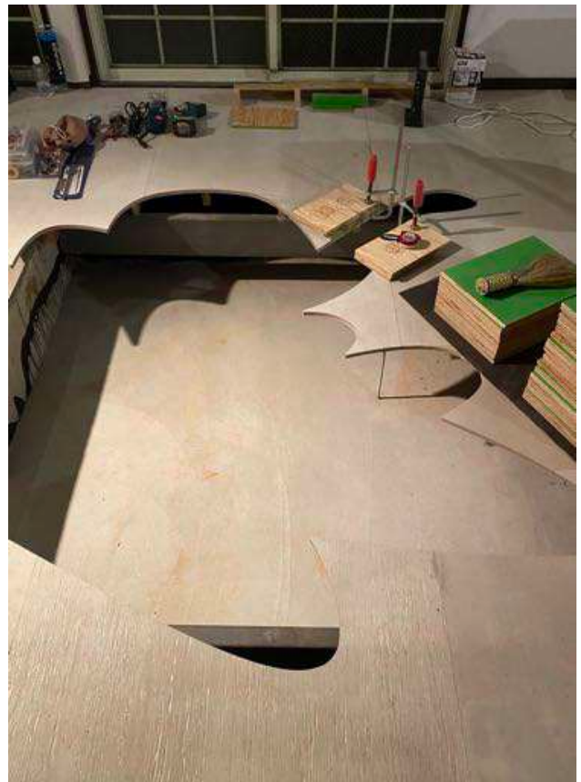
写真2-3 共用棟の製作風景
