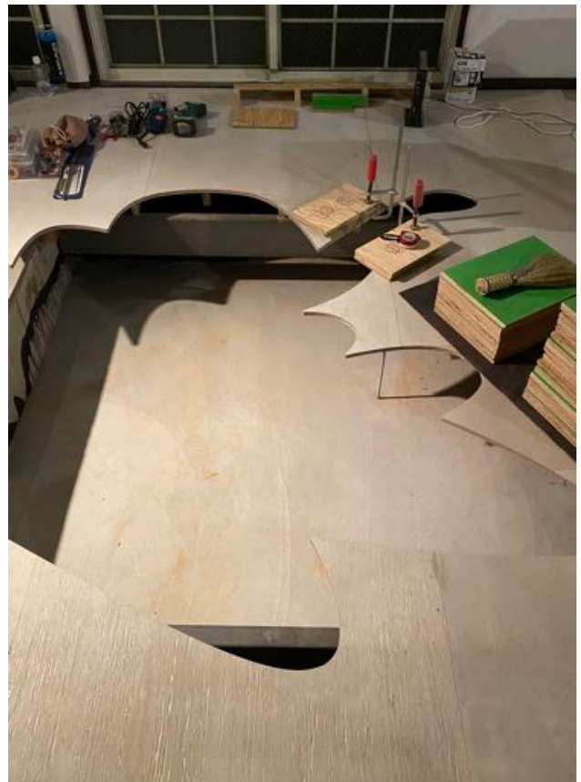
写真2-3 共用棟の製作風景
