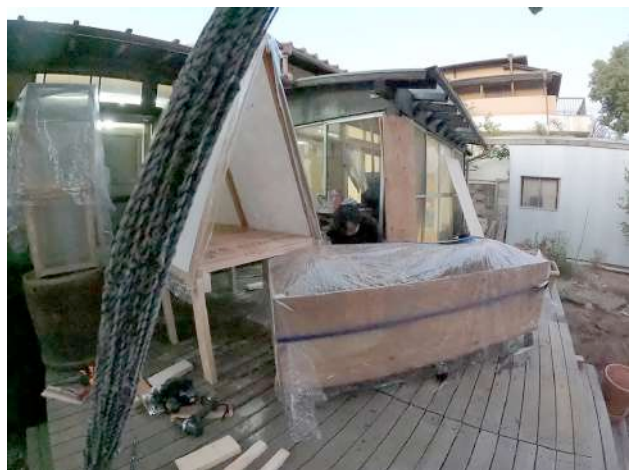
写真5-1 制作したテント。高床式になっており、床下にキャスターのついた温床が収納できるようになっている
