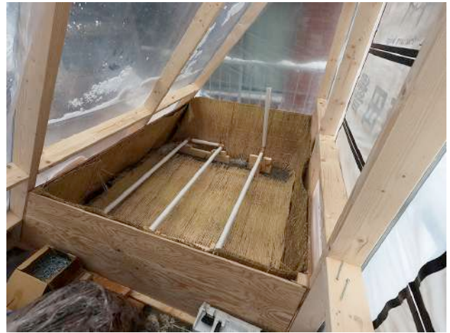
写真 4-4 テント内部。アースパイプを仕込んだ温床用の木枠。壁と床にむしろを敷いている
