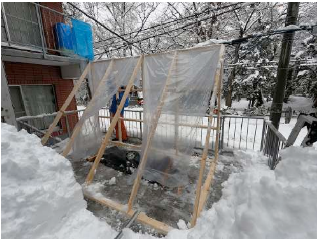
写真 4-1 2×4材を用いた骨組み。以下、「準備期間」中のすべての作業は主査と副査の二人で行なっている。
