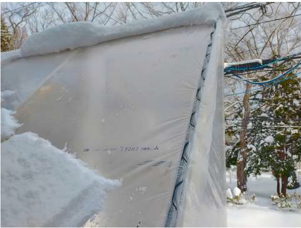
写真 4-2 銀色のレール状のものがビニペット。専用の黒いスプリングを用いてくぼみの部分にビニールを挟み込むようにして使う。農業用資材を扱っているホームセンターで入手できる
