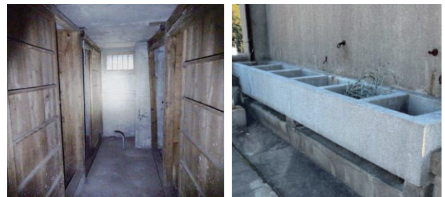
写真3-4 現存する48型の共用部分 (左: 地下倉庫, 右: 屋上の共用水栓)
