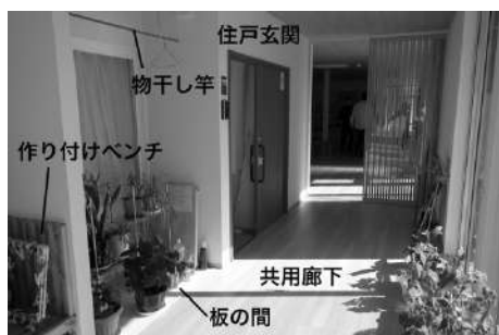
図 4-5 1・2 号棟住戸玄関周りの造作
