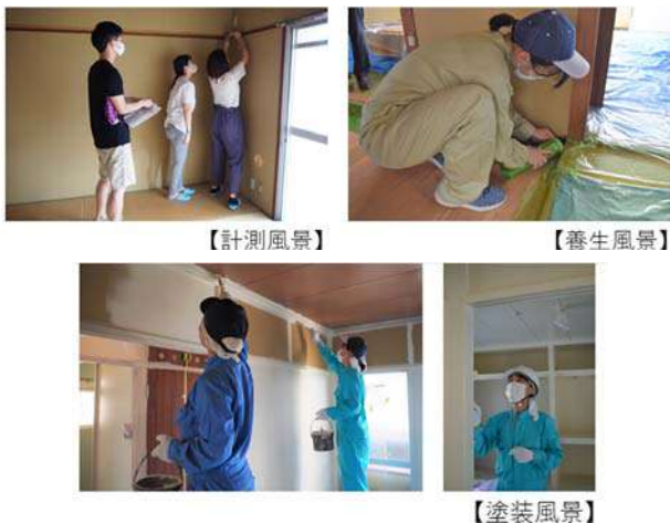
写真 2-3 日見地区市営住宅の改修工事の参画
