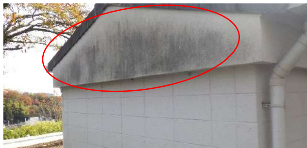
写真3-1 建物⑬の北西壁面。
