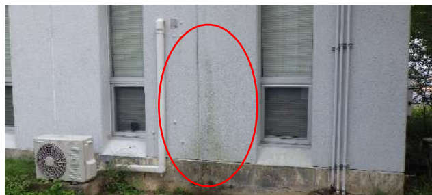
写真3-2 建物①の北西壁面。
