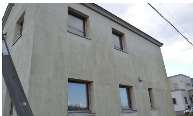
写真 1-1 外壁面での藻類の発生の様子
