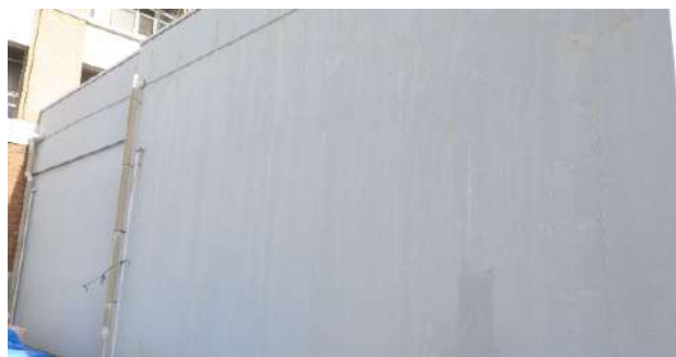
写真3-3 建物⑤の南西壁面。
