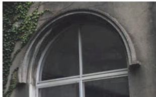
図 2-6 眉状窓上飾りとレイブル・ストップ (サッシは 1976 年に交換された新しいもの)
