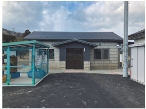
図 5-1 改修後の川房行政区公会堂
