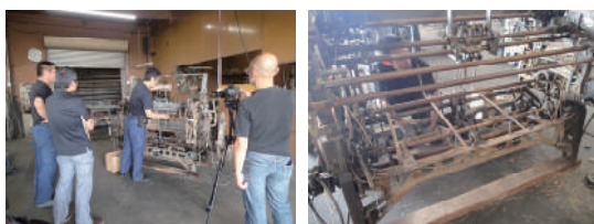
図3-6 解体作業の記録とさび付いたフレーム
