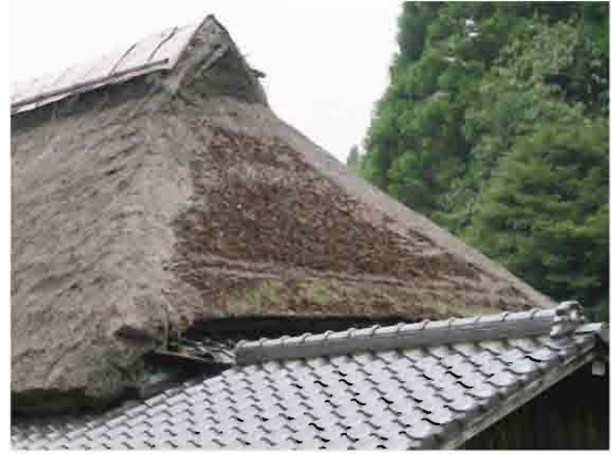
図 6-1 2018年9月時点の東面の状況
