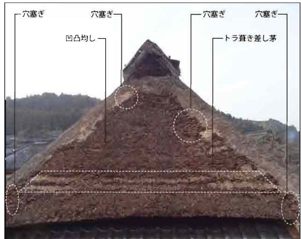
図 3-13 工事完了時の東側妻面と施工箇所
