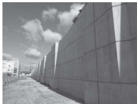
写真 1-2 気仙沼南部で建設中の堤防（2017 年 3 月）
