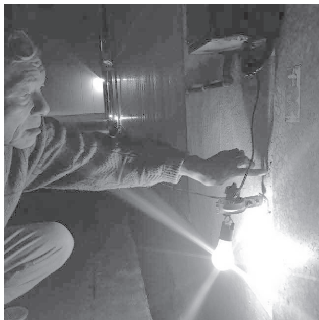
住宅外壁への照明設置位置の確認（2017年3月）。
