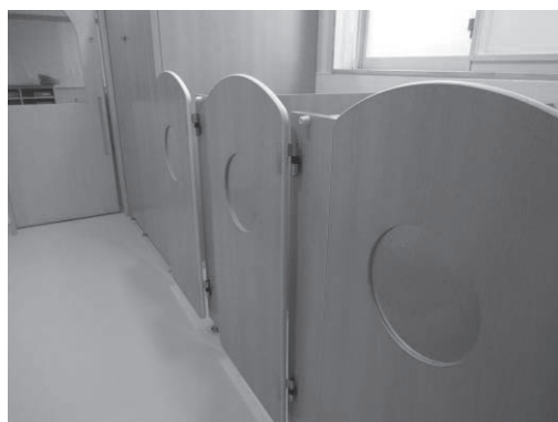
写真 3-4 隙間が大きく、指をはさまない構造のドア 1
