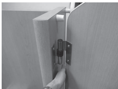
写真 3-5 隙間が大きく、指をはさまない構造のドア 2
