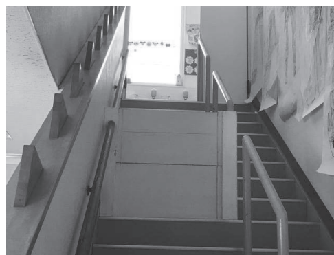
写真 3-9 階段の途中の柵
