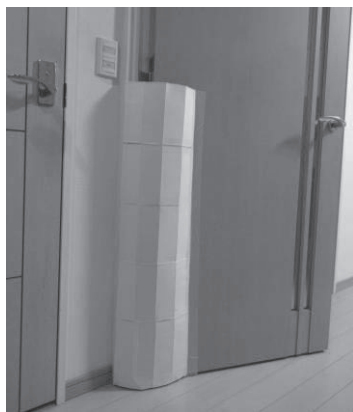
写真2-2 指つめ防止のために牛乳パックをドアの隙間に付けている
