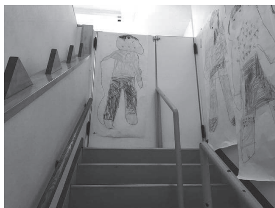
写真 3-8 階段の上部の柵
