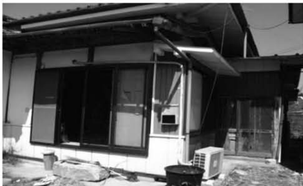
写真 2-3 浪江町実測住宅
