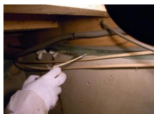
図 4-14 土台下 断熱材充填
