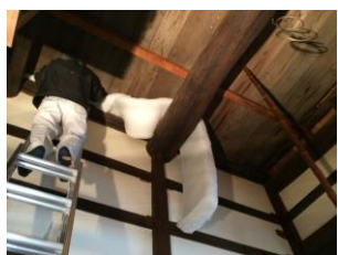
図 4-15 梁上 断熱材充填
