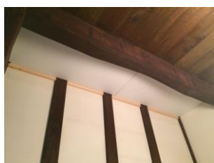
図 4-13 吹抜部の区画見上げ
