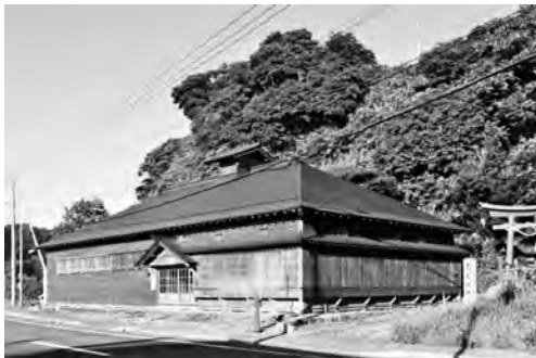
写真 4-3 茨木家中出張番屋修理工事竣工（2010年撮影）
