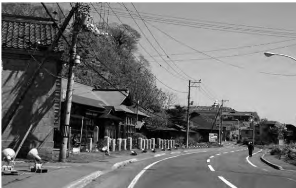
写真 4-1 小樽市祝津 道々小樽海岸公園線
