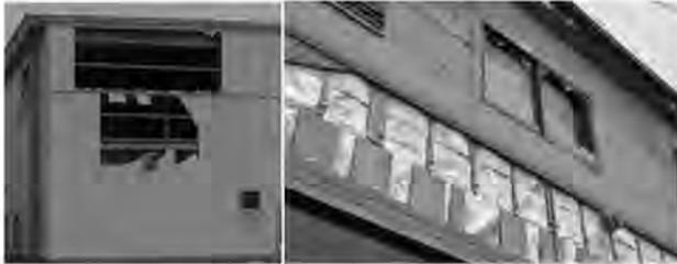
図1-1: 強風による低層建物壁面外装材被害(左: 2005年台風18号, 右: 2012年つくば市で発生した竜巻)
