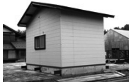
写真 5-1 実験対象とした木造建築物（小屋）
