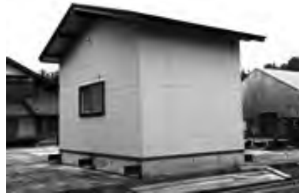
写真 5-1 実験対象とした木造建築物（小屋）
