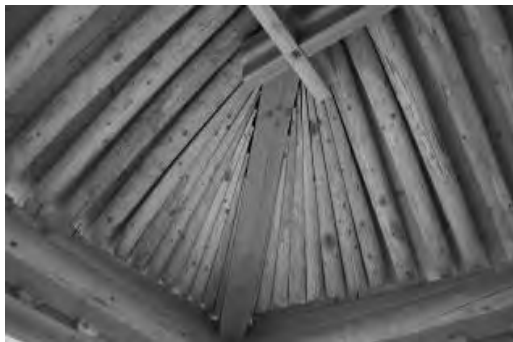
写真 5-6 隅部垂木施工状況
