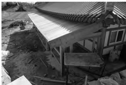
写真 5-1 増築工事中の韓屋
