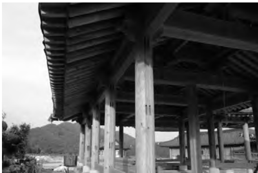
写真 5-3 構造材組立状況
