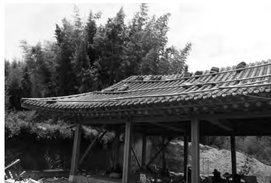
写真 5-5 屋根施工状況
