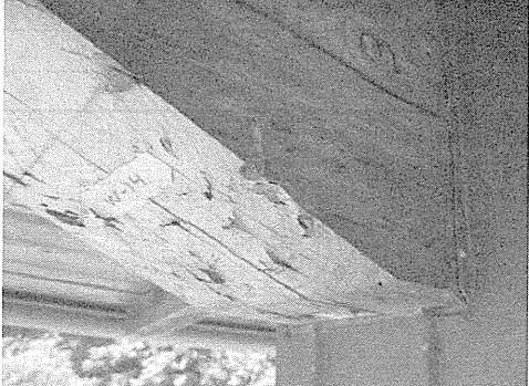
写真 2-3 母屋のアメリカカンザイシロアリ被害
