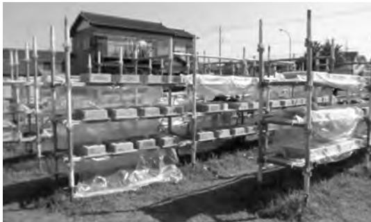
図4-2 土ブロックの養生および保管の状況
