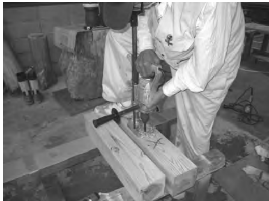
写真4-5 ボルト用穴開けの工程
