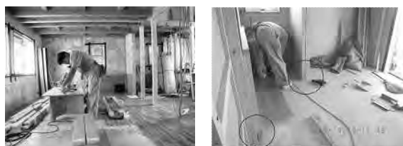
図 7-12 床材施工状況
