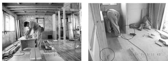
図 7-12 床材施工状況
