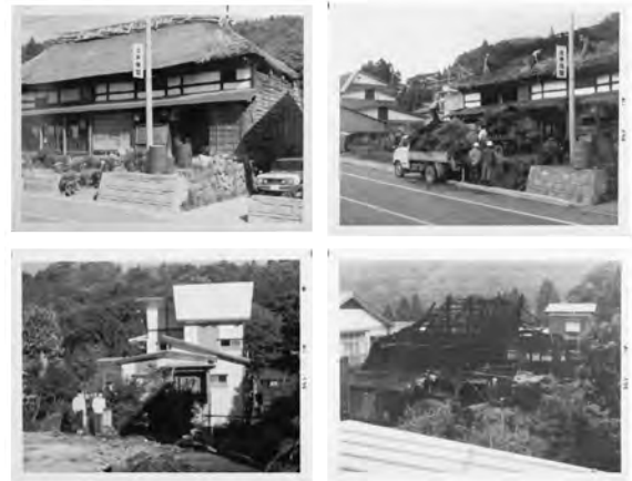
図 2-10 (左上から順に時計回りに) 解体直前の「雪に埋もれる山の村の家」、茅葺き屋根の撤去搬送中、同家の構造があらわになったとき、新築された家
