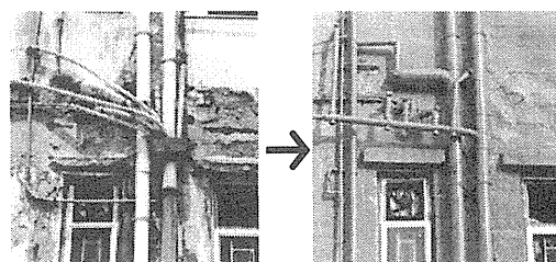
写真3-3 設備の補修(配管の取替え・整理)
