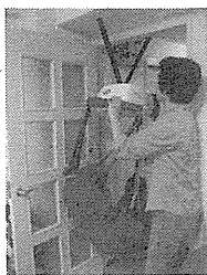
③モーターを移動。レールが不連続の部分では、レールからレールへとモーターをつり替える。
