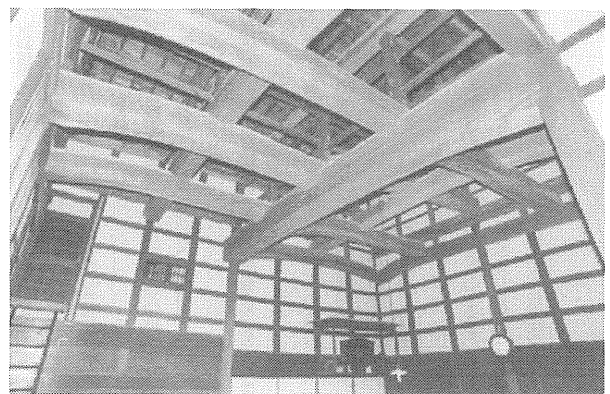
写真 5-1 臺所・土間の吹き抜け
