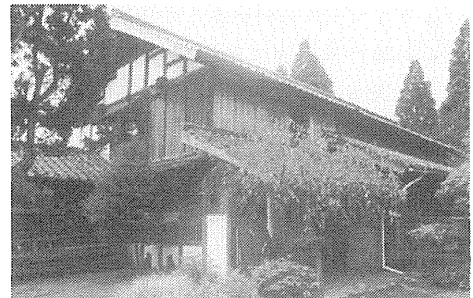
写真 6-3 市原朔雄家 外観
