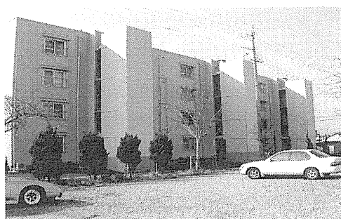
写真 1-1 階段室型 E V 設置例
