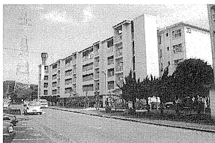
図・写真 6-3 33 号棟
