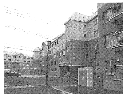
図・写真 6-1 R33 棟
