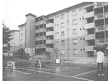
図・写真 6-2 11 号棟
