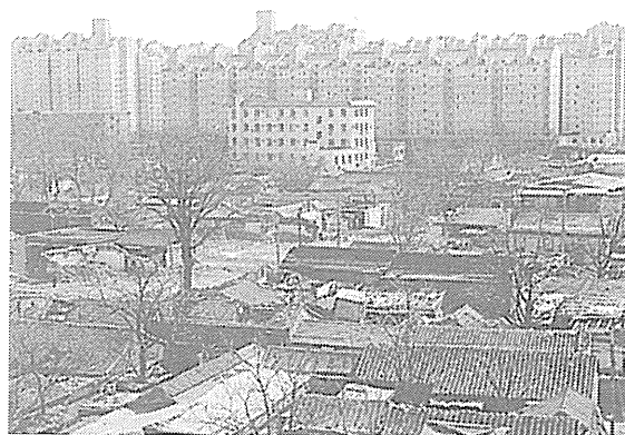
写真1-1：取り壊し中の平屋群（手前）と建て替え後の高層住宅（奥） （崇文区東花市、2004年2月撮影）
