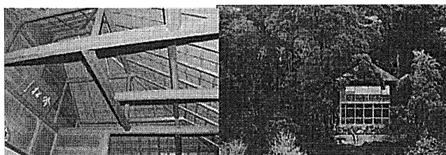
図 5-7 坂倉新兵衛邸内「山の茶亭」土間の天井と外観の写真
